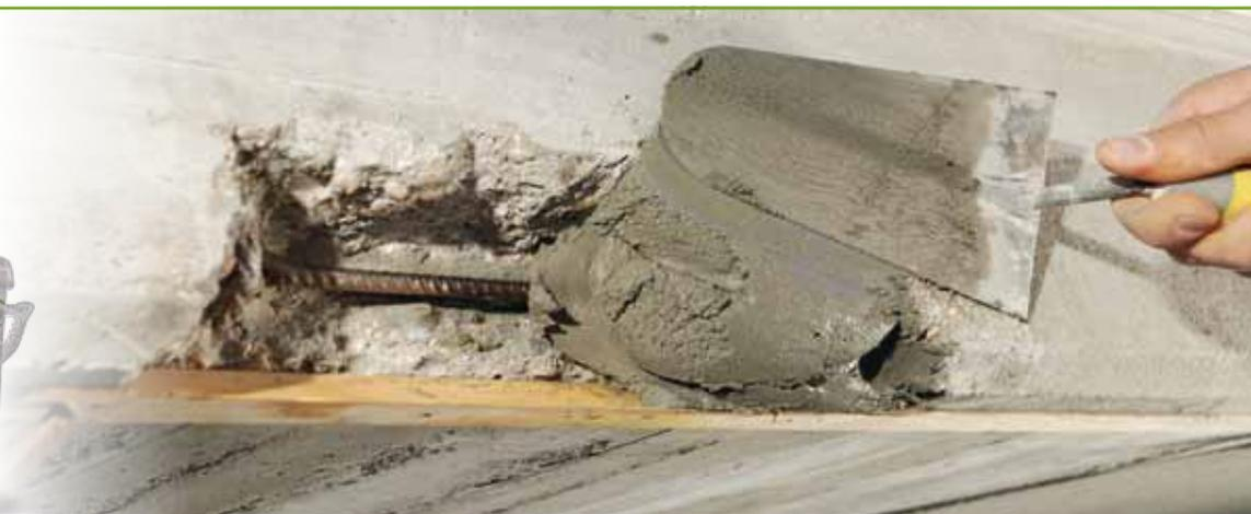
Технические ограничения и рабочие показатели обычных растворов на основе цемента с химическими добавками и сложных многослойных систем ремонта бетона, сегодня преодолел GeoLite® - революционный эко-совместимый минеральный геораствор, который пассивирует, восстанавливает, шпаклюет и предохраняет поврежденный бетон по ходу одной операции. Результат: восстановление стабильное естественным образом, которые кристаллизуют в монолит, обладающий долговечностью, свойственной горным породам.
